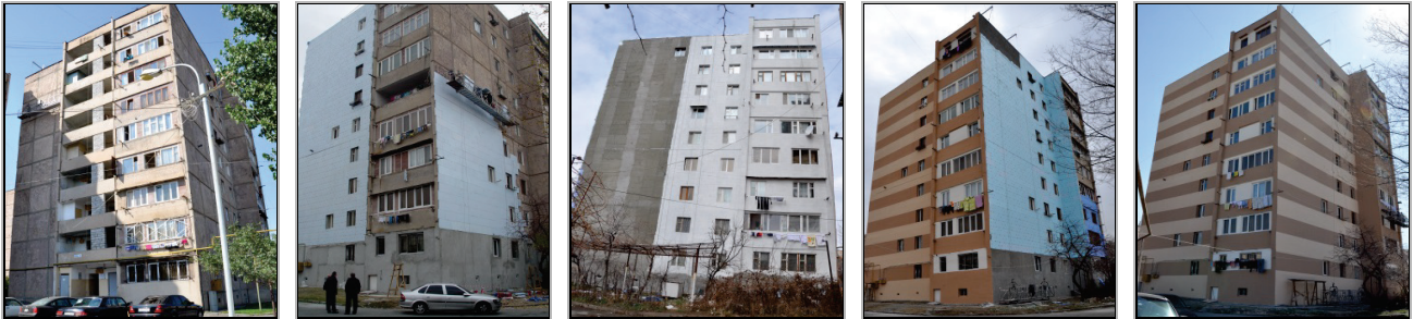
Նկար 22. Ջերմաարդիականացման աշխատանքների ընթացքը, ջեռուցման համար էներգիայի սպառման ցուցիչի անկում 177-ից 75 կՎտժ/մ 2 /տարի
