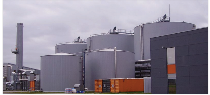
Կենսագործարանի անաերոբ խմորման տեղակայանքը (Լյուբեկ, Գերմանիա)
