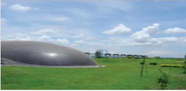
Կենսագործարանի անաերոբ խմորման տեղակայանքը (Լյուբեկ, Գերմանիա)
