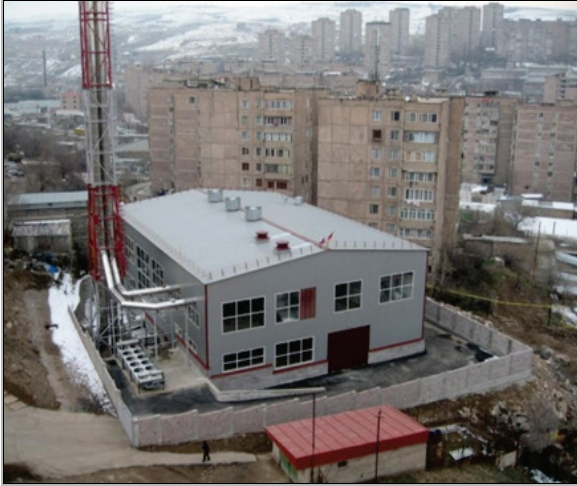
Նկար 37. Ավանի կենտրոնացված ջեռուցման վերակառուցված կայանը՝ 2 ՋԷՀԱ բլոկներով (Երևան, Հայաստան):
