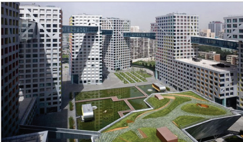
Նկար 32. Սթիվեն Հոլի Linked Hybrid-ը: Համալիրը հովացվում/ջեռուցվում է փակ սխեմայով 660 երկրաջերմային հորատանցքերի միջոցով (աջ պատկերին՝ 660 երկրաջերմային հորատանցքեր, յուրաքանչյուրը՝ 100մ խորությամբ, ջեռուցման/հովացման հզորությունը՝ 5000կՎտ)
