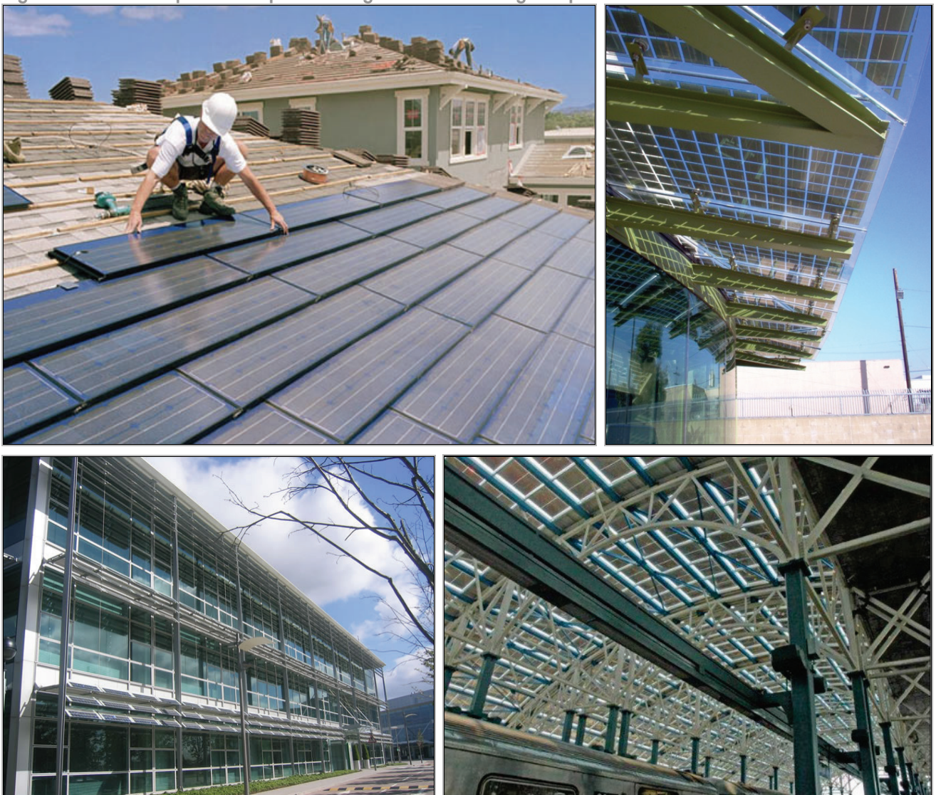
Նկար 4. Շենքի տարրերին ՖՎ պանելների ինտեգրման չորս օրինակ:
