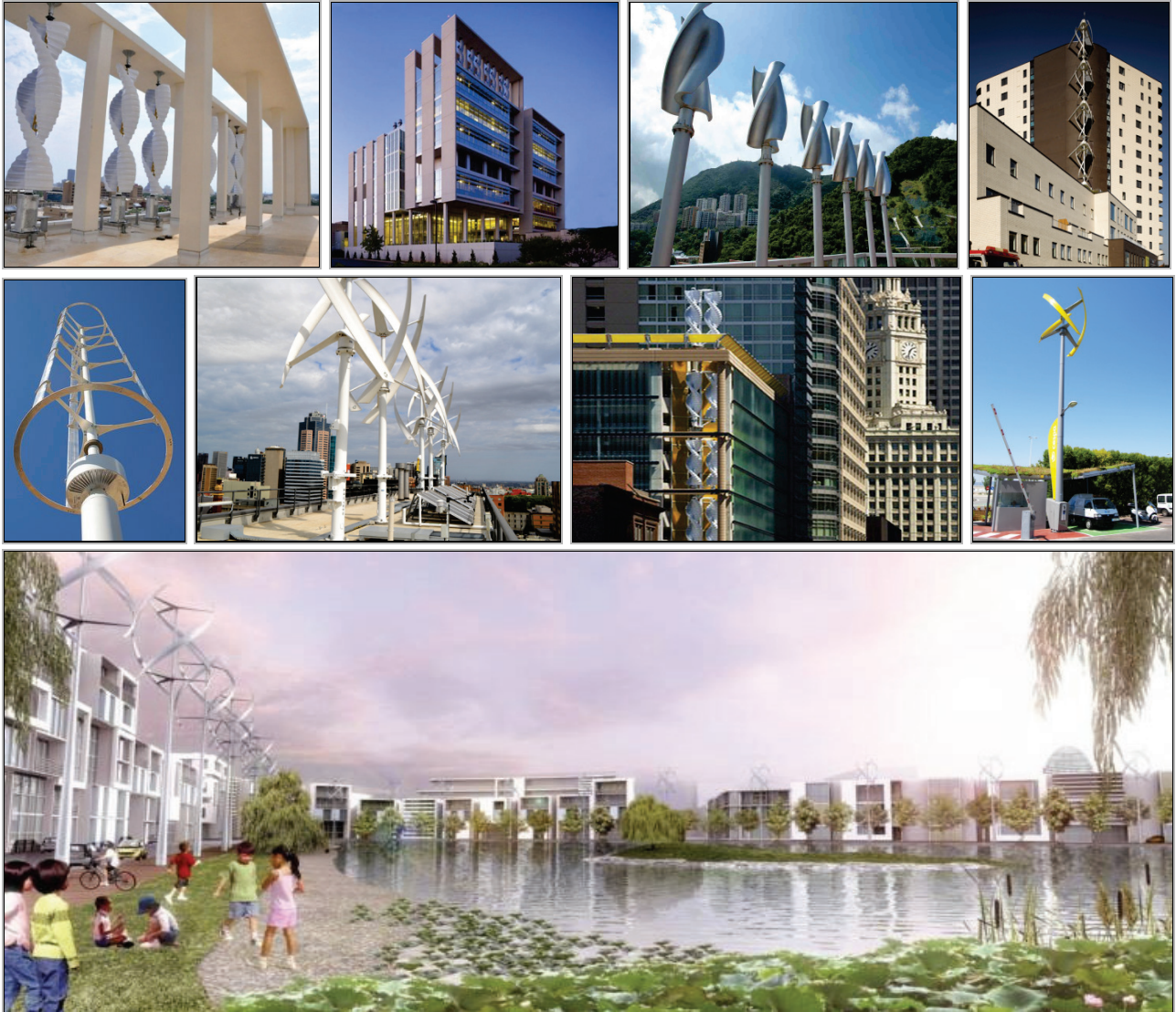
Սկար 24. Շենքերում և թաղամասերում կիրառվող ուղղահայաց առանցքով հողմային տուրբինների օրինակներ:
