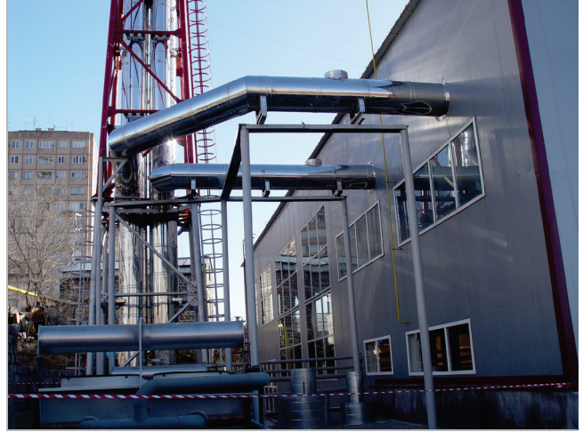
Նկար 37. Ավանի կենտրոնացված ջեռուցման վերակառուցված կայանը՝ 2 ՋԷՀԱ բլոկներով (Երևան, Հայաստան):
