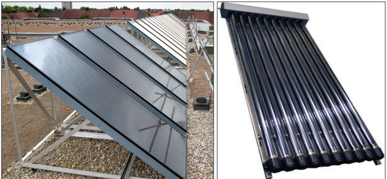
Նկար 14. Արևային ջերմային կոլեկտորները լինում են երկու տեսակ՝ հարթ պանելներ (ձախից) և վակուումային խողովակներ (աջից):
